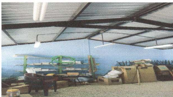
Foto 9: Sustitución de lamparas tipo LED + Sustitución de plafoneras + Sustitución interruptores simples + Sustitución de tomacorrientes dobles + Reparación de cableado eléctrico
