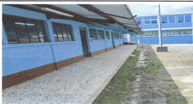
Foto 5: Pintura en muros exteriores e interiores
