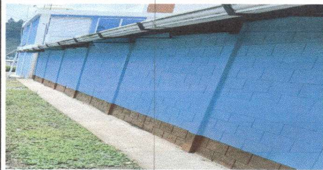
Foto 4: Sustrucción de canal de PVC + Reparación de bajada de agua pluvial, tubo PVC 3"
