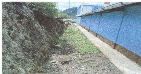
Foto 8: Reparación de planchas de concreto de patio
